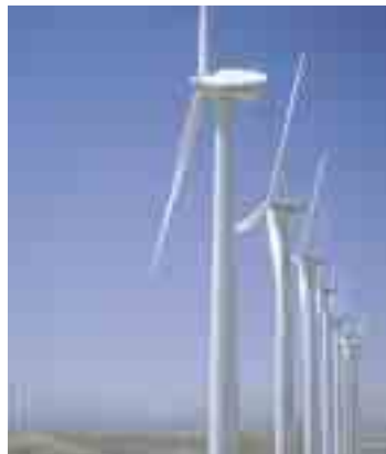
Ecotècnia, parque eólico.
